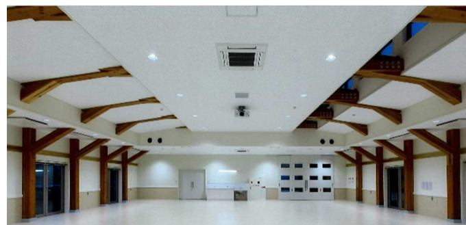
機能訓練室 (1.5mスパンを合掌梁とタイバーで天井高3.9mを確保)
