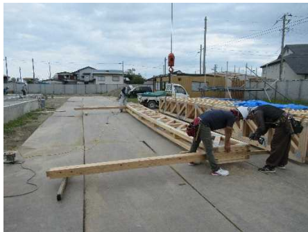
広いスパンのコネクタトラス梁、軽量で扱いやすく少人数での施工を可能にした
