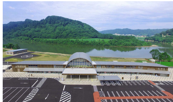
道の駅ふたつ外観
