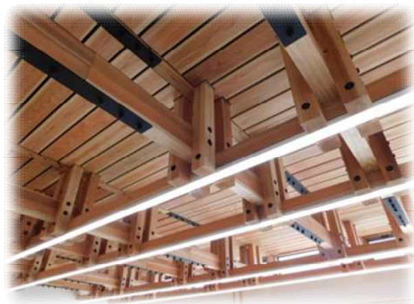
木鉄ハイブリッド工法による組立梁
