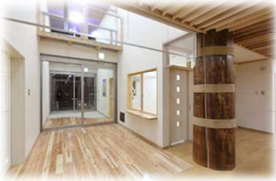
エントランス（床に県産CLT、村産大スギ柱）
