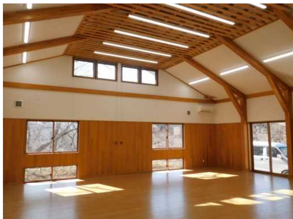
研修室の腰壁（スギ小幅板を使用）
