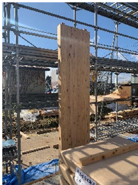
縦ログ構法の施工状況
