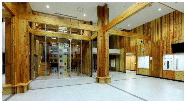
玄関ホール (秋田スギのCLTの壁で構成)
