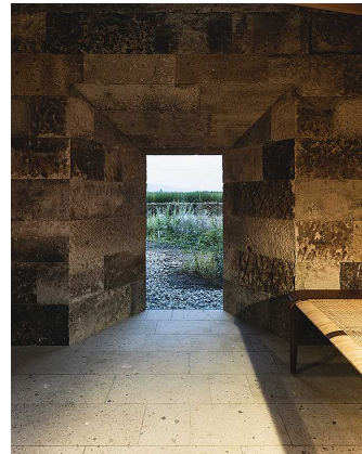
エントランス(床・壁は院内石)
