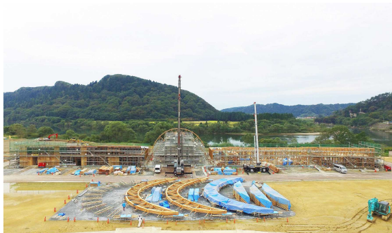
アーチトラス吊込状況
