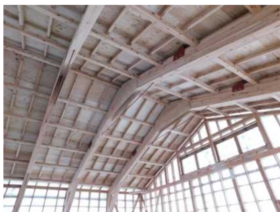
小屋組方式による天井部
