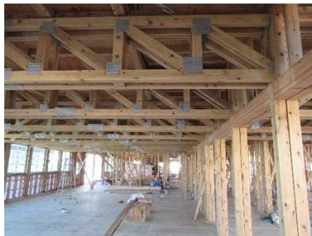
柱梁、秋田スギ主体の構造材、在来軸組工法
