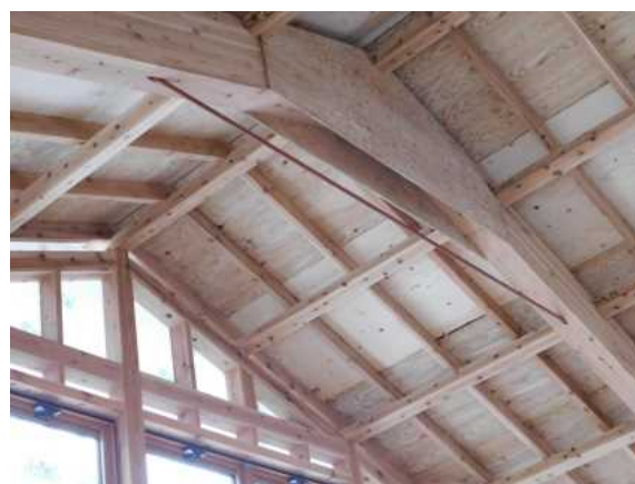
部材を鉄筋にすることで大空間を創出
