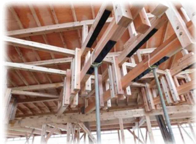
組立梁の施工状況
