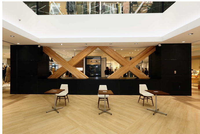
【1階エントランス耐震補強構造】
