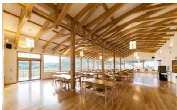
レストラン (方丈トラスの天井)
